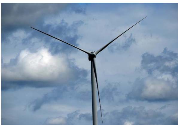
Rys. 2. Łopaty wirnika turbiny ustawione w „chorągiewkę”
