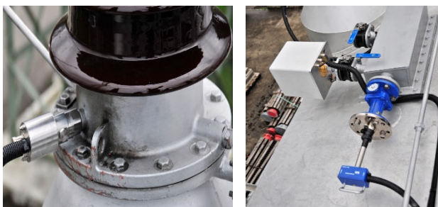
Rys.9 Sonda metody standardowej (po lewej) i sonda UHF (po prawej)
