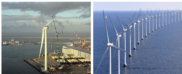
Rys.4. Elektrownia wiatrowa zlokalizowana na terenie portu i w morzu
