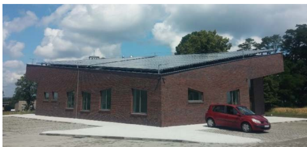
Rys. 3. Budynek przychodni w Przyszowicach ze 126 panelami fotowoltaicznymi o mocy 30 kW
