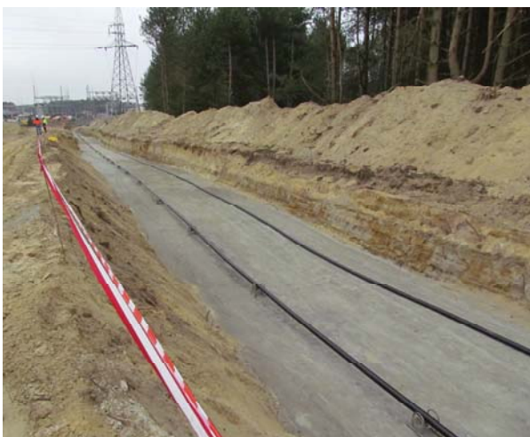
Rys.6. Widok wykopu kablowego dla czterech linii kablowych 110 kV
