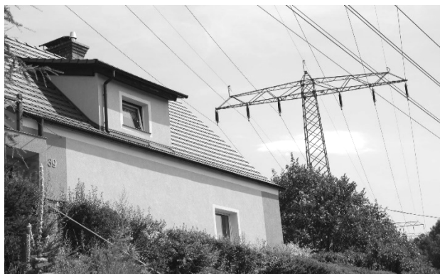
Rys13. Przykład zbliżenia budynku mieszkalnego do NLWN
